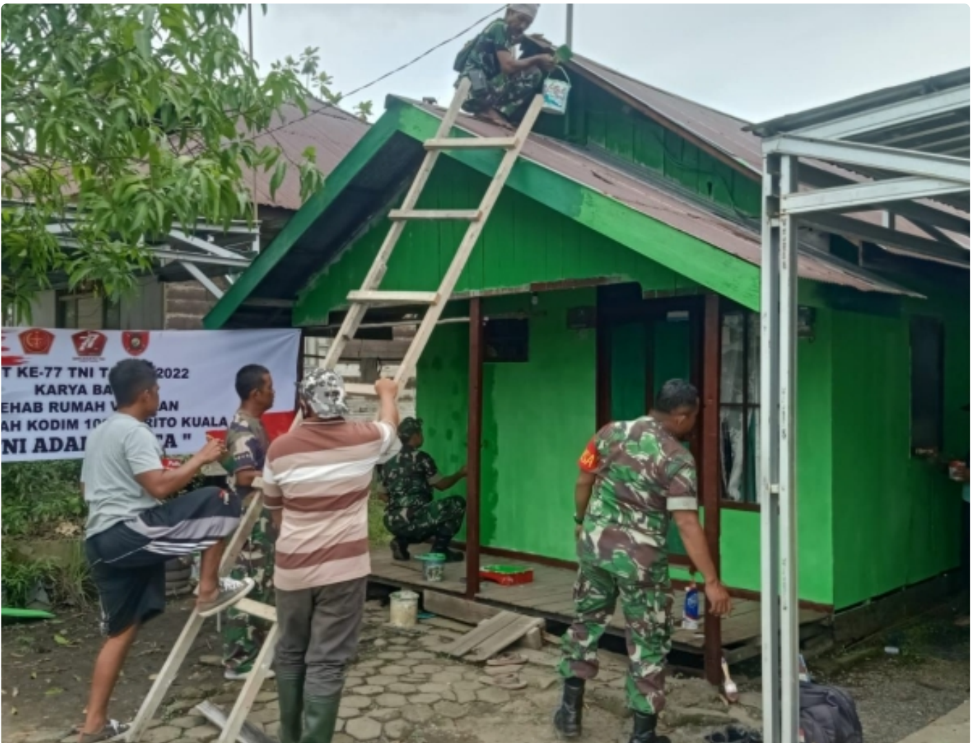
Anggota Kodim 1005/Barito Kuala Rehab Rumah Veteran
