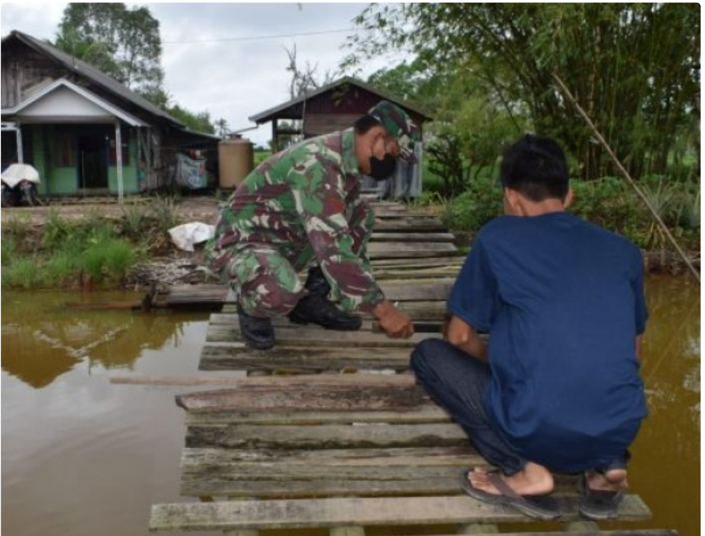
Babinsa Kodim 1005/Barito Kuala Bantu Perbaikan Jembatan
